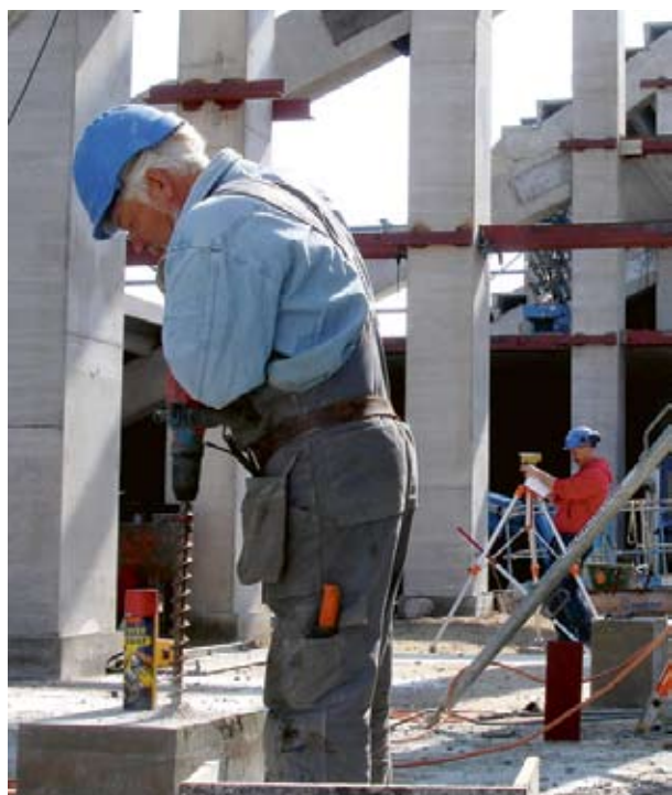
Ett arbetslag på 25 man monterar betongstommen till Swedbank Stadion.
