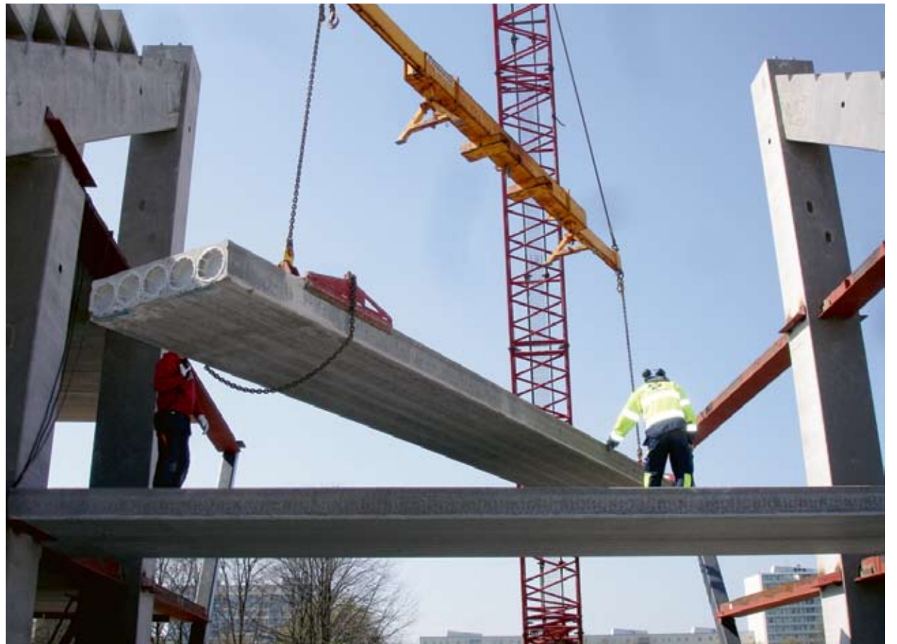
Ännu ett betongbjälklag till Swedbank Stadion lyfts på plats.
