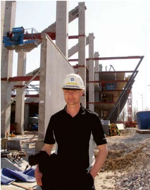
– Det är otroligt kul att få vara med om att bygga den här stadion, säger montageledaren Magnus Johansson.
